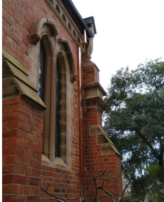
PVC PIPE REPLACE MENT
